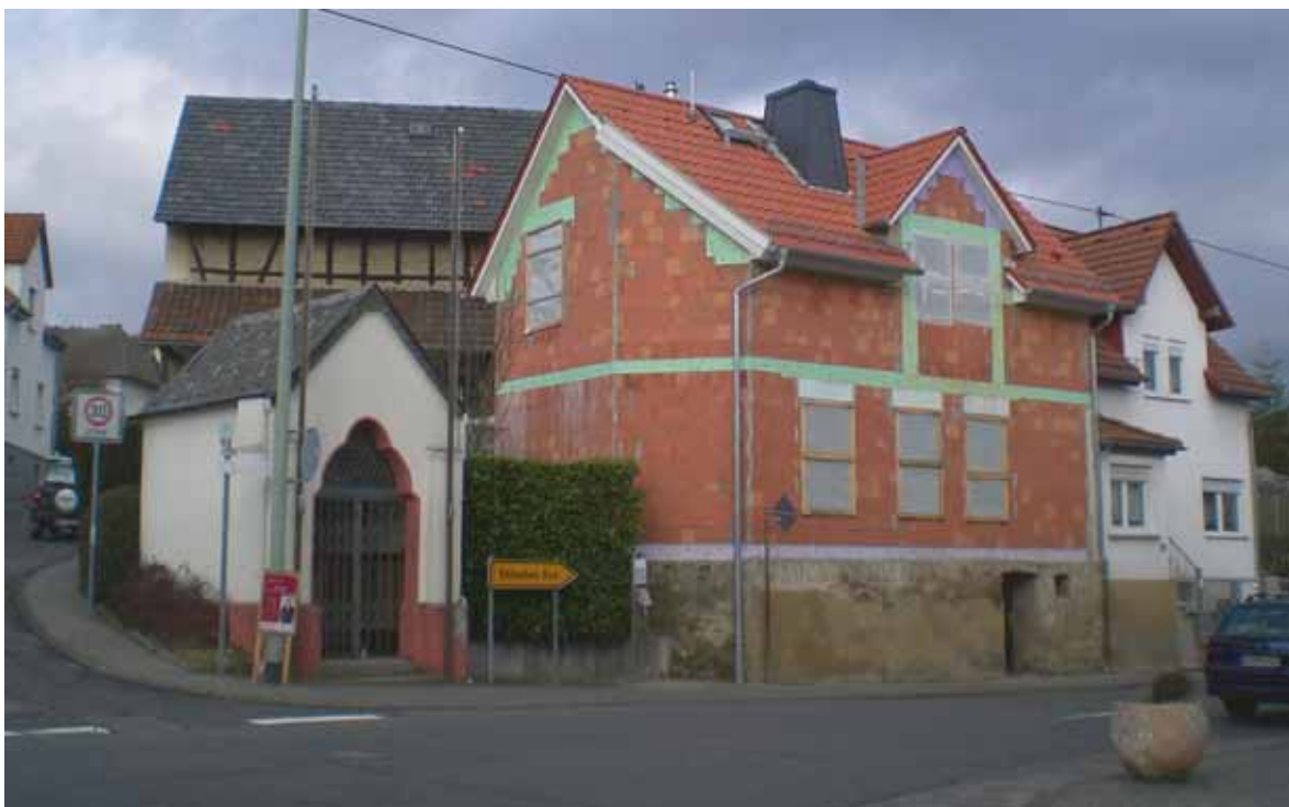
Der sanierte Anbau (noch unverputzt)
