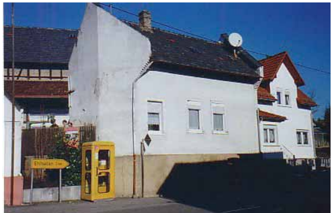
Der alte Anbau (rechts neben der Telefonzelle)
