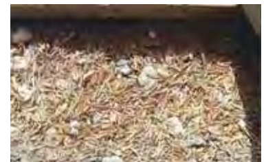
Die Haferspreuschicht in der Decke zum alten Dachboden
